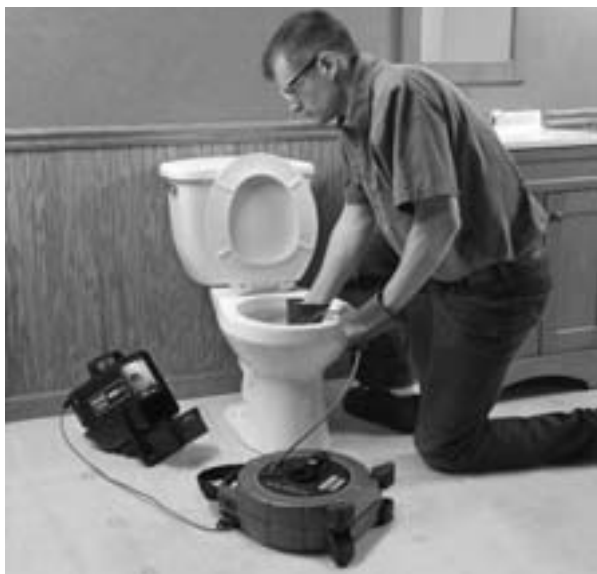
Figura 15 – Una inspección en marcha
