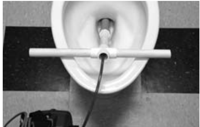
Figura 24 – Empleo de un tubo-guía de PVC
