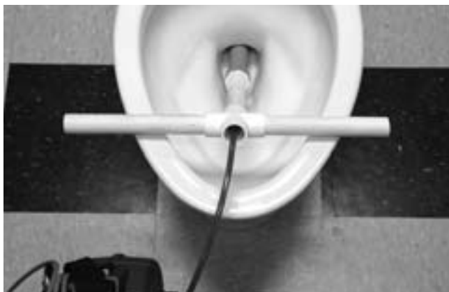
Рис. 24. Использование направляющей трубы из поливинилхлорида
