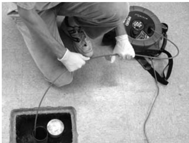
Obrázek 29 – Umožnění kabelu vytvořit smyčku může způsobit zalomení kabelu při zatlačování do bubnu
