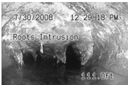
Obrázek 25 – Obrazovka se snímkem se zobrazeným textem, časem a vzdáleností (vzdálenost měřená od systémového nulového bodu)
