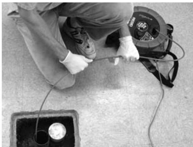
Figur 29 – Løkker på kablet kan forårsage, at kablet snor sig, når det skubbes ind i tromlen
