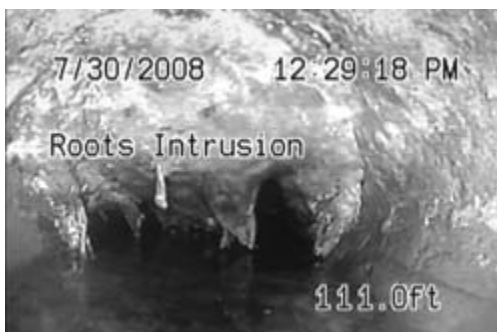
Εικόνα 25 – Οθόνη με λεζάντα, ένδειξη ώρας και απόστασης (Η απόσταση μετράται από το σημείο αναφοράς του συστήματος)
