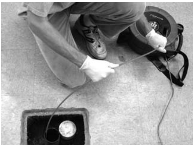
Kuva 28 – Oikea tekniikka kaapelin syöttämiseksi takaisin rummulle
