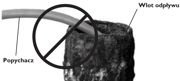
Rysunek 23 – Unikać ciągnięcia pod ostrymi kątami.
