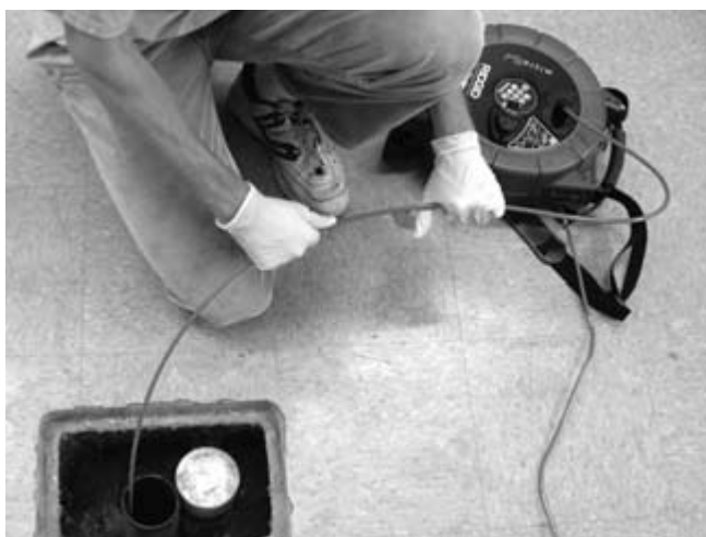
Rysunek 29 – Pętle przewodu mogą się powodować płątanie przewodu przy jego wsuwaniu do bębna.
