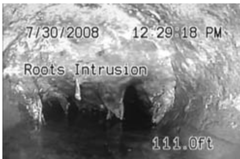
Rysunek 25 – Ekran ze wskazaniem tekstu slajdu, zegara i odległości (odległość zmierzona od punktu zerowego systemu)
