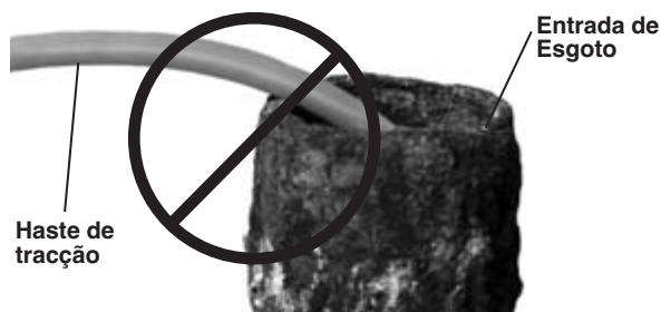
Figura 23 – Evite Puxar em Ângulos Apertados
