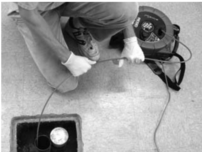
Figure 29 – Permitindo a cabo faça nó pode torcer o cabo enquanto empurrado para tambor
