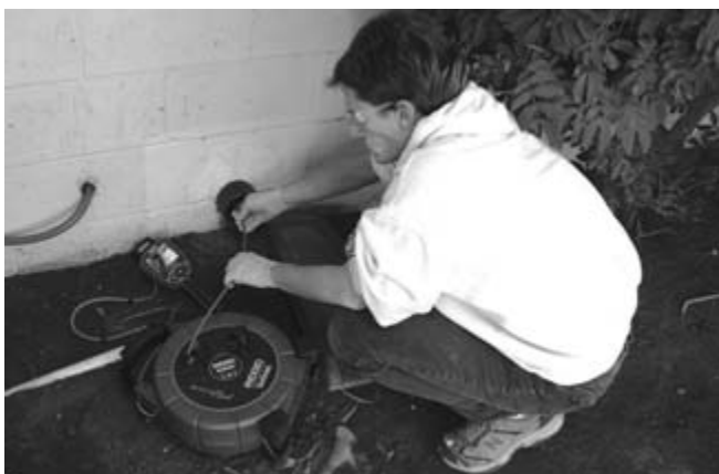
Figura 21 – Utilizar o microReel
