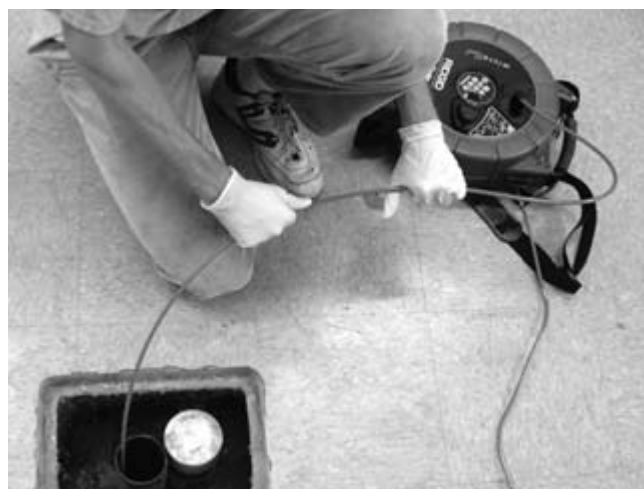
Figura 29 – Lăsarea cablului să formeze bucle poate cauza încolăcirea cablului în timp ce este împins pe tambur
