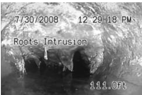
Рис. 25 – Отображение на экране текста слайда, времени и расстояния (Расстояние отсчитывается от нулевой точки системы)
