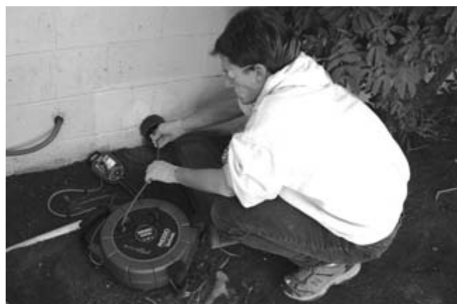
Рис. 21 – Пользование проталкивающим кабелем microReel
