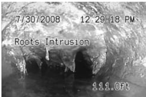
Figur 25 – Skärmen visas med text, tid och distans (Distansen mäts från systemets nollpunkt)
