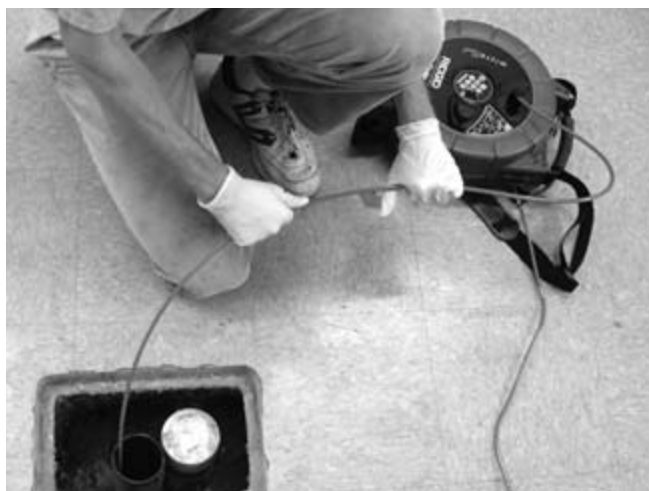
Figur 29 – Om kabeln bildar öglor kan den knäckas när den trycks in i trumman
