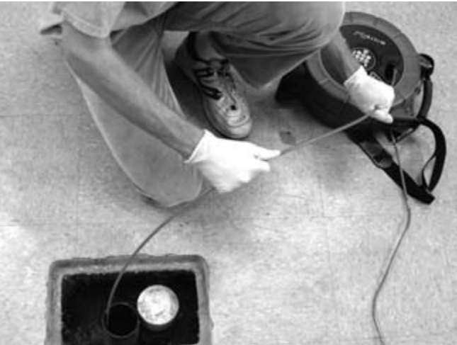
Şekil 28 – Kabloyu Tambura İtmek İçin Düzgün Teknik
