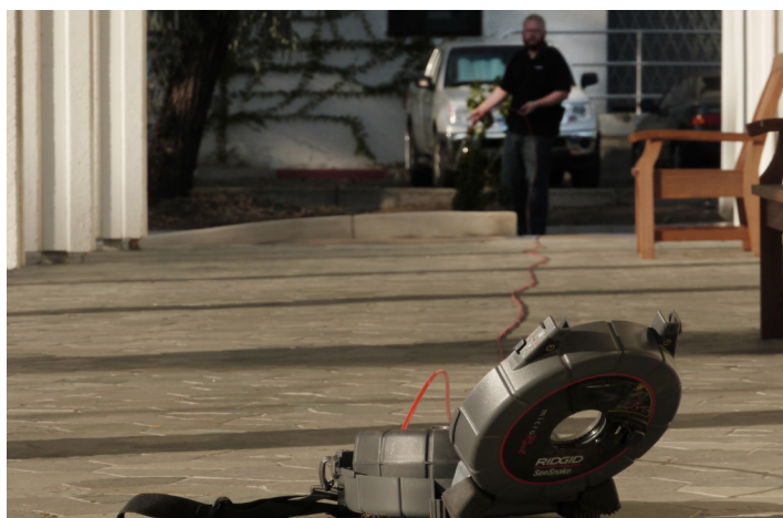
Sliku 2 – Ispravljanje pritiskajućeg kabla
