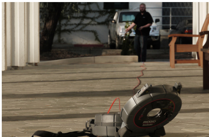
Figura 2 – Esticando o cabo de tração
