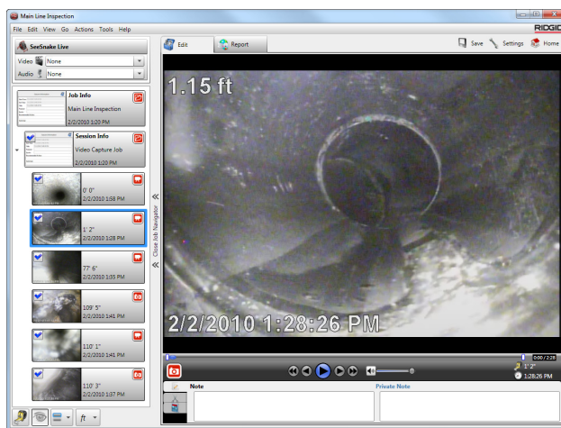
Afbeelding 63 – Media controleren en bewerken in SeeSnake HQ
