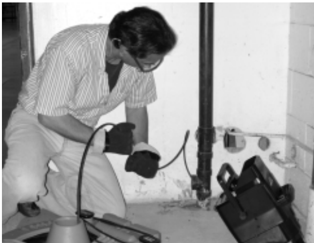
Figure 14 – Manière incorrecte de tenir le câble d'avancement
