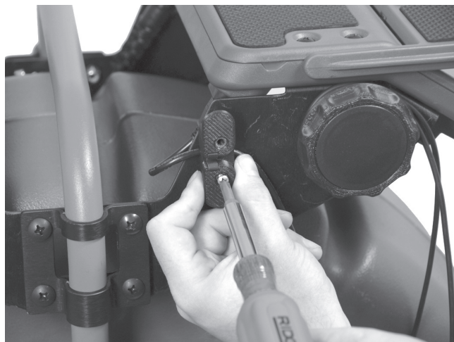
Obrázok č. 16 – Montáž obalu kábla (USB kábel umiestnený pod obalom)
