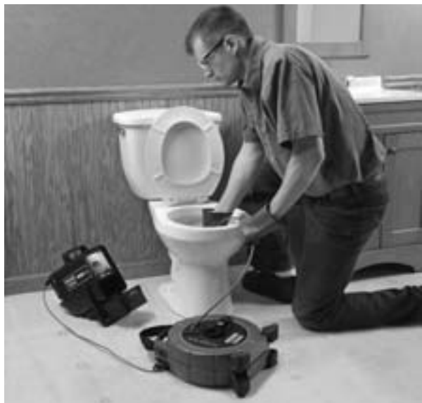
Figure 15 – Inspection en cours
