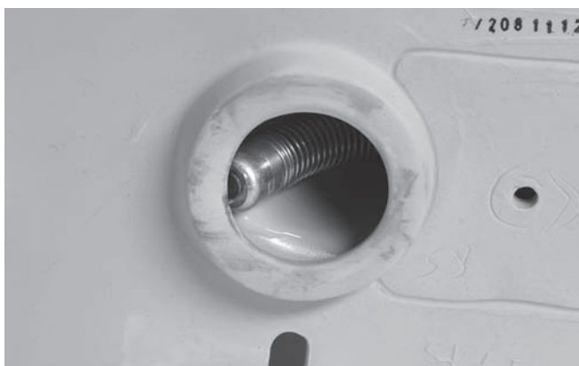
図 20 — 曲がり部分で止まったカメラヘッド
