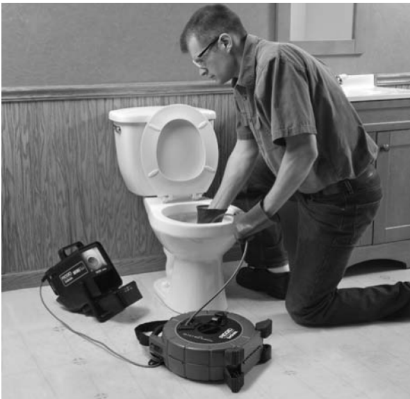
Figura 15 – Realizando uma inspeção
