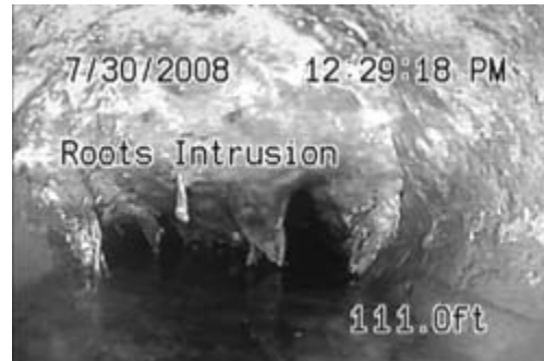
Kuva 25 – Näyttö, jossa näkyy diateksti, kellonaika ja etäisyys (etäisyys mitattuna järjestelmän nollapisteestä)
