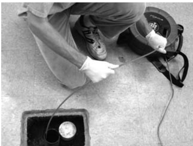
Kuva 28 – Oikea tekniikka kaapelin syöttämiseksi takaisin rummulle
