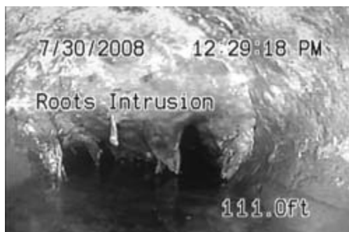
Slika 25 – Prikaz na zaslonu s pomičnim tekstom, prikazanim vremenom i razmakom (udaljenost izmjerena od sistemske nultočke)
