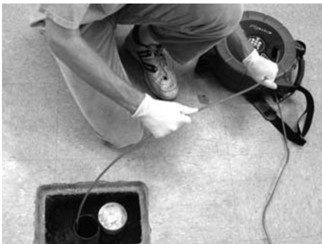
28. ábra – A kábel dobba való visszahúzásának helyes technikája
