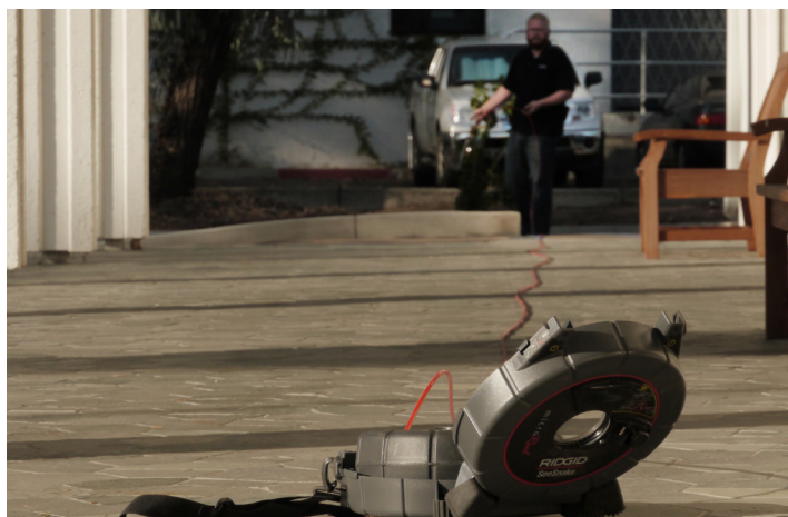
Obrázek 2 – Rovnání vodícího kabelu
