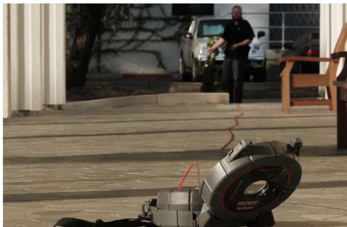
Slika 2 – Ravnanje potisnega kabla
