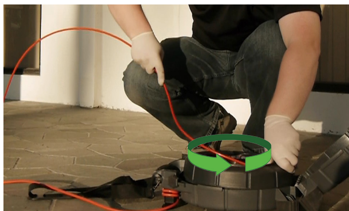
Slika 4 – Vodenje potisnega kabla v boben
