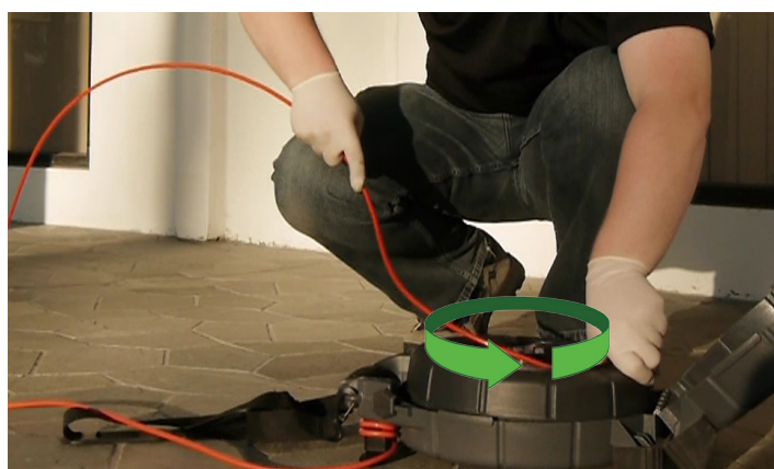
Figur 4 – Led push-kabelen inn i trommelen
