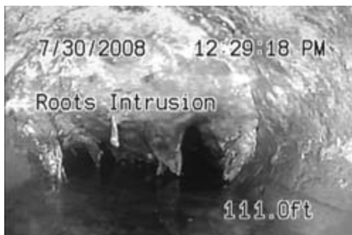
Slika 25 – Prikaz na ekranu sa pomičnim tekstom, prikazanim vremenom i rastojanjem (udaljenost izmerena od sistemske nulte tačke)
