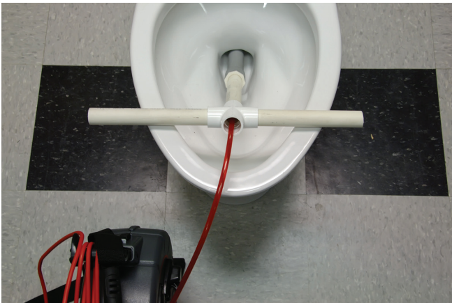
Abbildung 22 – Benutzung eines PVC Führungsrohrs
