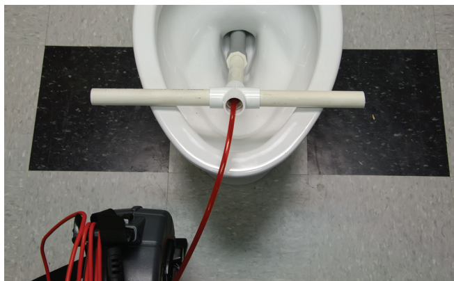
Figura 22 – Utilizando un tubo de guía de PVC
