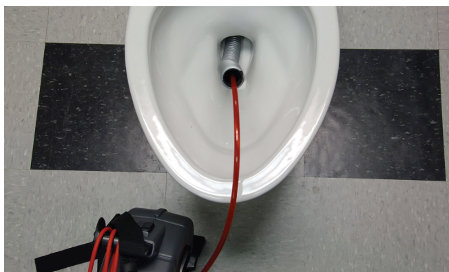
Figura 23 – Utilizando un tubo de guía flexible
