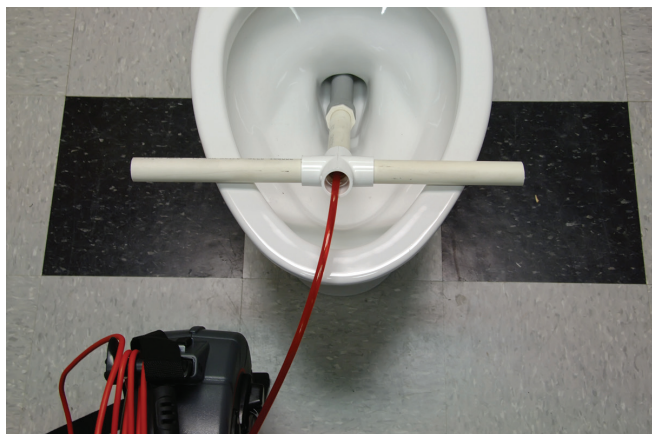
Figure 22 – Utiliser un tuyau-guide en PVC
