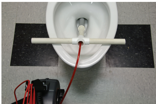
Figura 22 – Usare un tubo guida in PVC
