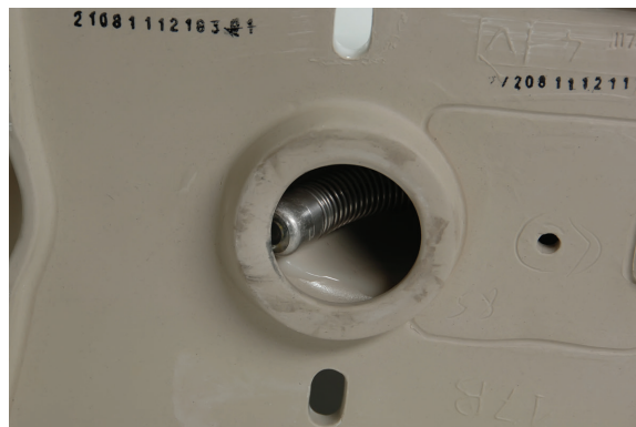
Afbeelding 16 – Camerakop geblokkeerd in bocht
