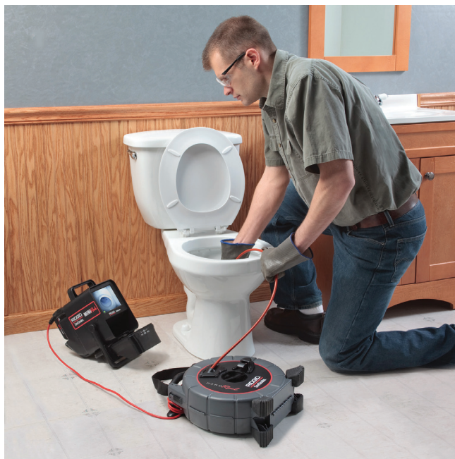
Afbeelding 13 – Een inspectie uitvoeren
