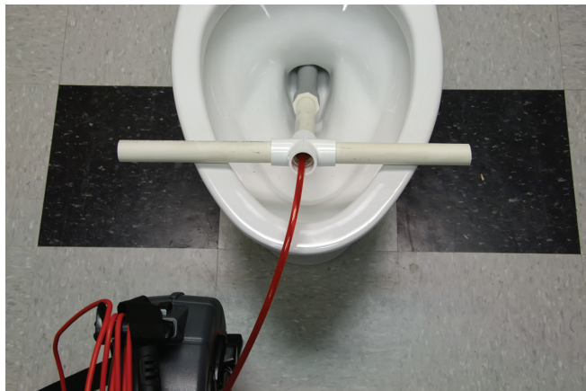
Рисунок 22 – Использование ПВХ направляющей трубки
