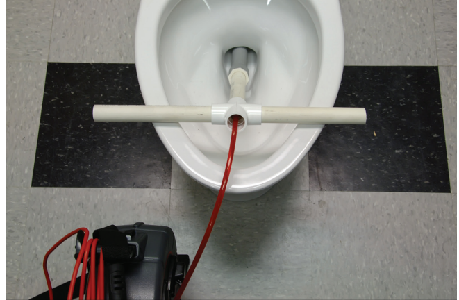
Figür 22 – PVC Kılavuz Borusunu Kullanma
