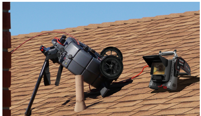
図 10 – 屋根の上での検査中のrM200及びキックスタンド
