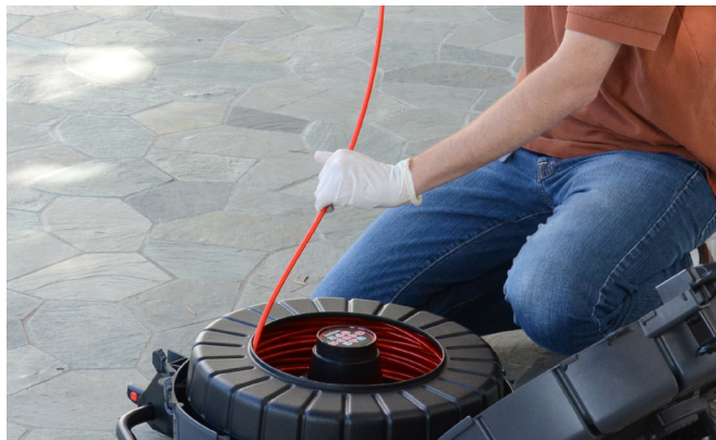
図 19 - プッシュケーブルをドラム内に誘導する
