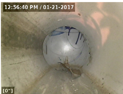
Con guía de la tubería
