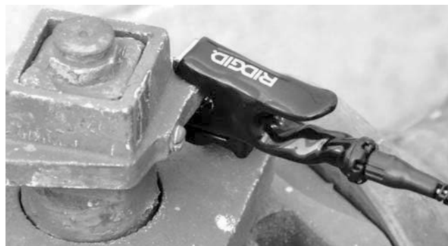
Figure 8 – Connexion du câble au conducteur ciblé.
